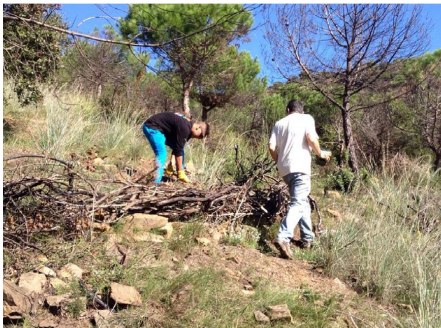
Fent feixines per evitar l'erosió. Projecte de la font del Gos. Arxiu CPNSC
